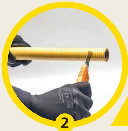
! L'extrémité sectionnée du tuyau onduleux est tranchante, il faut être très prudent lors de la découpe de la gaine et du maniement du tuyau. !
