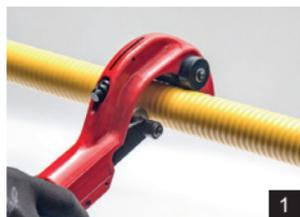
1 Découper le tuyau PLT BD CONNECT à l'aide d'un coupe-tube.
