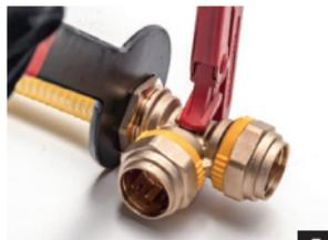
5 Serrer l'écrou à la main puis à l'aide de clés. Les écrous sont serrés en butée (jeu nul), le corps du raccord reste fixe.
